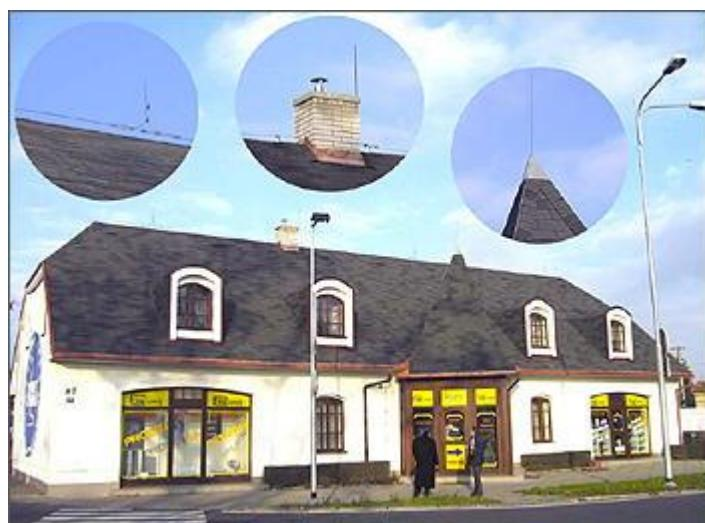
На приведенных фотографиях показан дом, система молниезащиты которого выполнена в виде так называемой молниеприемной сетки. Так как здание имеет несколько усложненную архитектуру, помимо сетки на выступающих элементах конструкции крыши устанавливаются дополнительные штыревые вертикальные молниеприемники, которые должны обеспечить увеличение зоны защиты от прямого удара молнии. Существует
