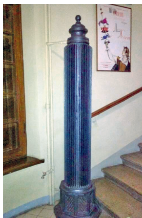
Исторический коллектор в магазине братьев Елисеевых на Невском проспекте
