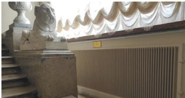
В 1911-1914 годах в зданиях Императорского Эрмитажа началась реконструкция систем отопления с устройством водяного отопления и вентиляции по проекту инженера Н.П. Мельникова, в которой использовалось тепло отработанного пара от паровых машин электростанции. Электростанция Зимнего дворца вырабатывала электричество для нужд зданий дворцового комплекса с 1886 по 1921 год и обеспечивала теплом помещения Эрмитажа с 1912 года до начала 1930-х годов.
