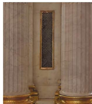
Однако и аммосовские печи были несовершенны. Они согревали помещения только во время топки. Как только огонь гас, печи и каналы быстро остывали, и в помещения начинал поступать холодный воздух. В итоге печи топили постоянно и каменные полы в расположенных над ними помещениях первых этажей так разогревались, что для их охлаждения приходилось на лагах настилать паркет, под который через отдушины в наружных стенах поступал холодный воздух с улицы.
